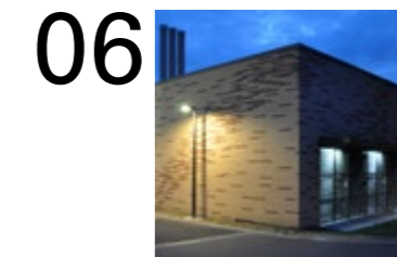
06 Energiezentrale Hochschule Aschaffenburg
