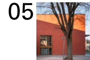
05 Institutsgebäude Universität Bamberg
