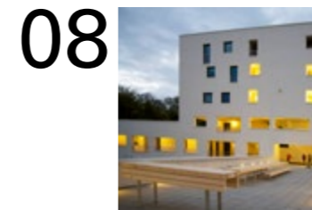
08 Wohnanlage »Jules et Jim« Neu-Ulm
